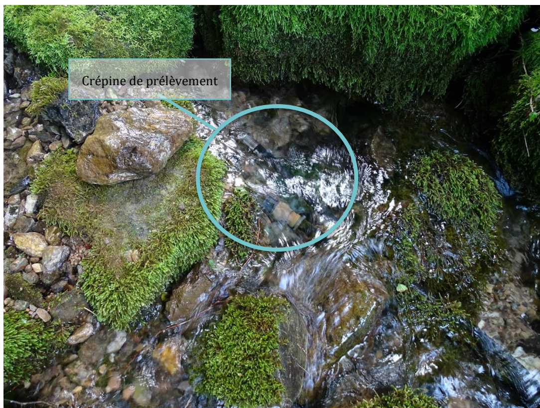
Illustration 12 : Cliché de la crépine de prélèvement installée à même l'écoulement issu de l'émergence captée
