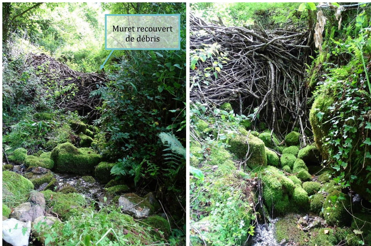
Illustration 22 : Environnement en amont du captage de « Riou Sourd »
